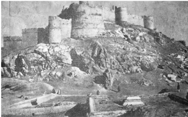
بالاحصار کابل پس از خرابی
